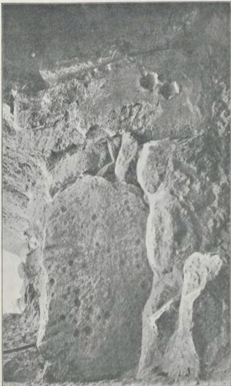
Abb. 4. Mauer mit Orthostaten in Graben IV.
