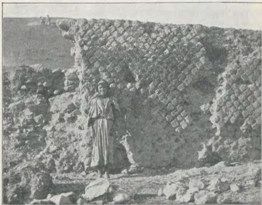
Abb. 15. Mauer aus Gußwerk mit Retikulatverkleidung.
