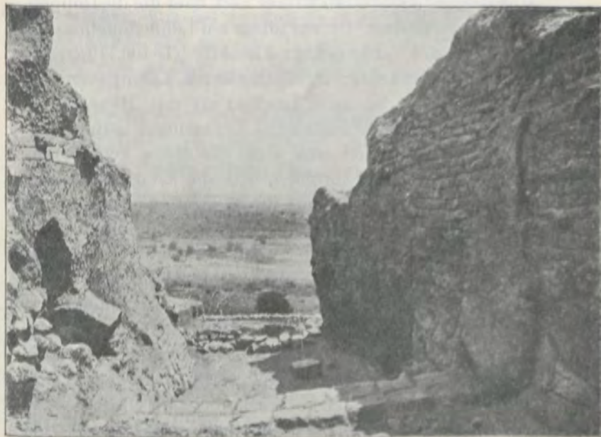
Abb. 10. Blick auf den Innenraum zwischen Zitadelle und Vormauer im Nordosten, von Westen aus.
